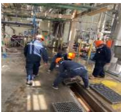
รูปที่ 9 การทำความสะอาดรางระบายน้ำ
